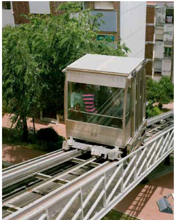
▲ L'ascensor inclinat de Ciutat Meridiana comunica l'estació de Rodalies de Torre Baró i la parada de metro de Ciutat Meridiana de la línia 11.
