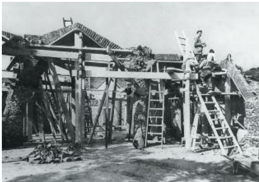
La cripta de la Colònia Güell en construcció, l'any 1910. L'arquitecte inventa un sistema de bastides econòmic, basat en el reciclatge dels materials, eficaç i de muntatge senzill.
